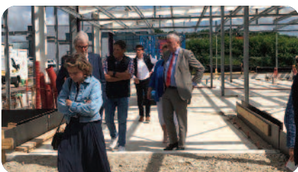
Pose du premier bois de la Maison de santé de Gainneville, désormais en service
