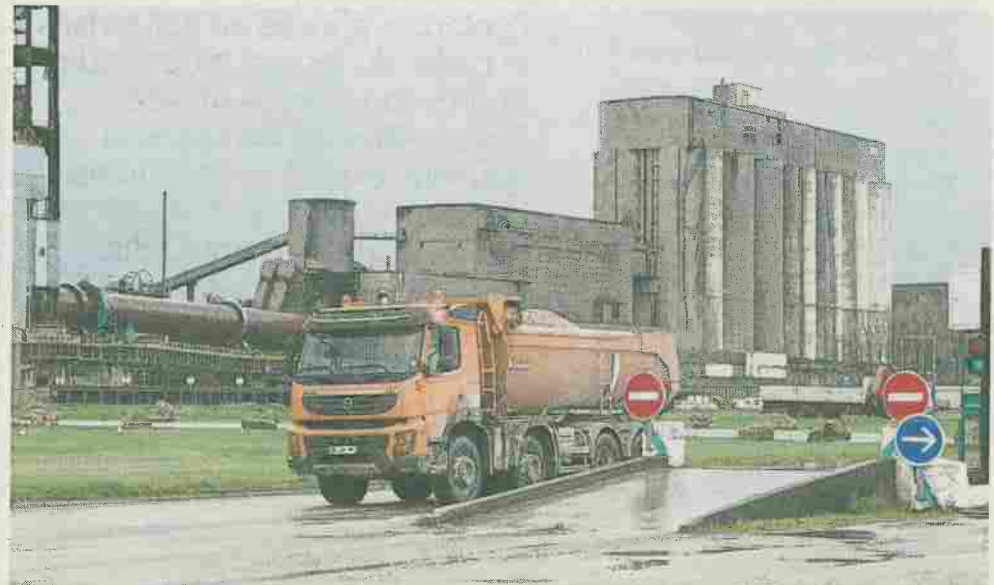
La cimenterie Lafarge de Saint-Vigor d'Ymonville où une centaine de postes ont été supprimés
