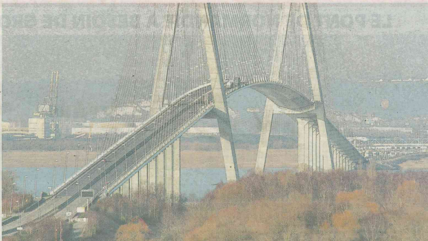
La CCI Seine Estuaire est gestionnaire du pont de Normandie lancé en 1995 et du pont de Tancarville en service depuis 1959. (Photo archives PN)
